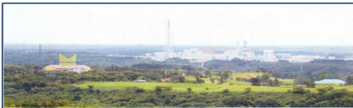
六ヶ所原燃PRセンター正面全景と原子燃料サイクル施設（インターネット掲載画像を引用）
