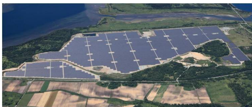
鷹架地区のソーラー発電所 ユーラス六ヶ所ソーラーパークホームページより引用
